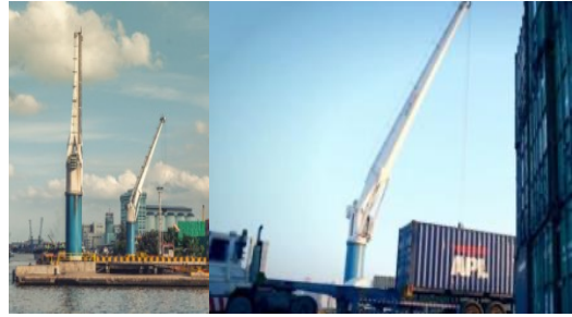
ข.) เครนยกตู้คอนเทนเนอร์บริเวณหน้าท่าแบบหมุน (Jib Crane)
